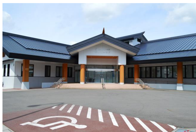
由利本荘市役所矢島総合支所
